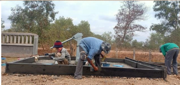
興建孔井旁的平台
