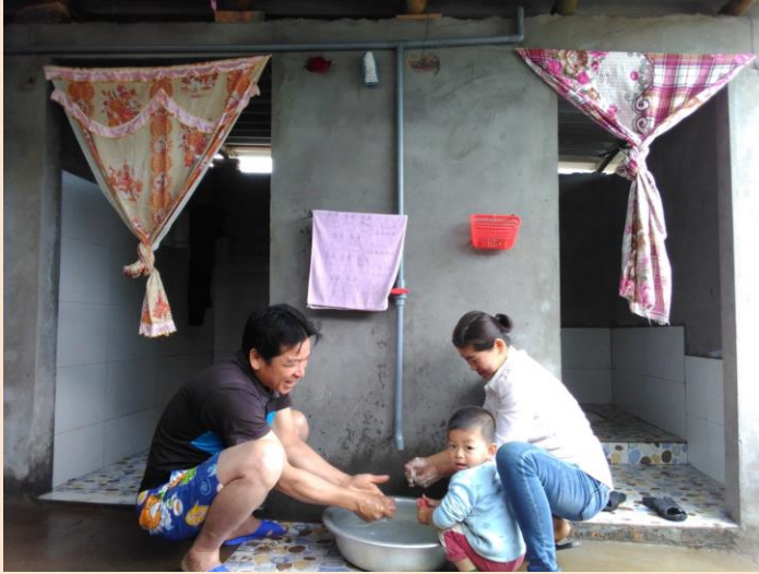
已完成的洗手台和廁所
