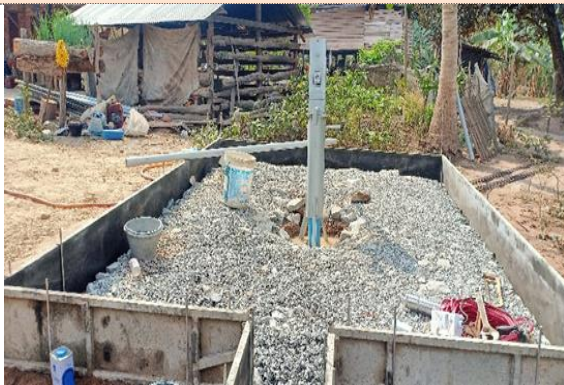
水質測試後進行平台建設
